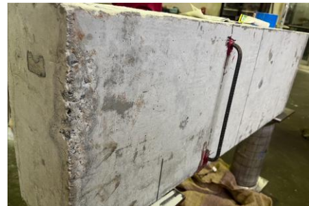
รูปที่ 4 การติดตั้ง Rehab Bar
